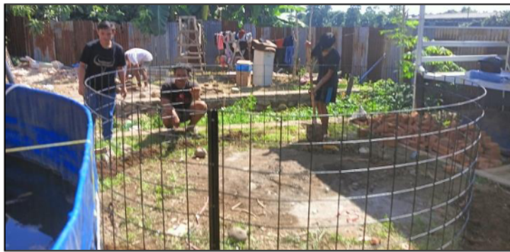
Gambar 2. Pembuatan Kolam dan Pemasangan Aerator
