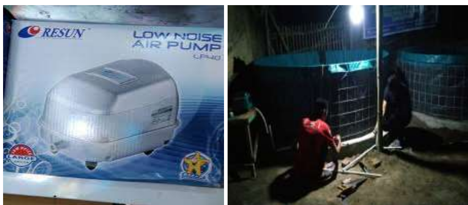
Gambar6. Pemasangan Instalasi aerasi di pasang di 2 kolam bulat dengan jumlah batu aerasi masing – masing kolam sebanyak 6 buah. Posisi batu aerasi disesuaikan sehingga oksigen bisa merata di semua kolom air kolam. Aliran oksigen di setting dengan kecepatan 10 L/menit.
